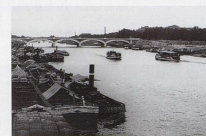
Le pont de Bercy / Pont de Bercy
