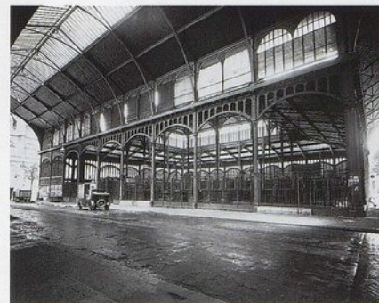
Un des pavillons Baltard / A Pavillon Baltard
