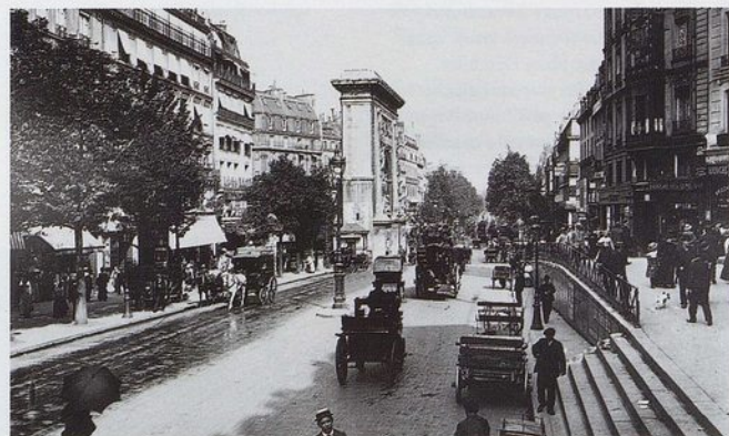
La porte et le boulevard Saint-Denis / Porte and Boulevard Saint-Denis
